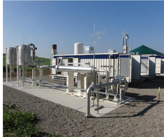
Abbildung 10 - Fließbild einer typischen Biogasaufbereitungsanlage nach dem Prinzip der Gaspermeation; Abbildung der Biogasaufbereitungsanlage Kisslegg, Deutschland mit einer Rohgaskapazität von 500m 3 /h (Quelle: AXIOM Angewandte Prozesstechnik)
