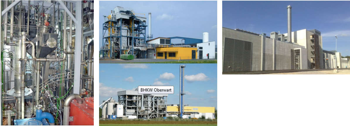
Abbildung 2: Wirbelschichtvergasung TU Wien, Oberwart, Güssing, Senden
